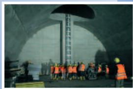
In der Kaverne des Einhornstunnels
