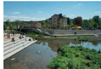
09 Mündungsareal des Josefsbachs
